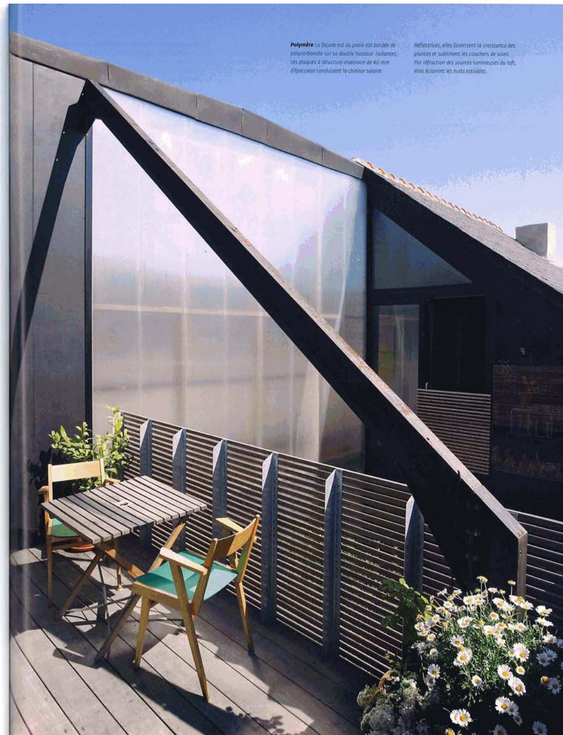
**Polymère** La façade est du patio est bordée de polycarbonate sur sa double hauteur. Isolantes, ces plaques à structure alvéolaire de 40 mm d'épaisseur conduisent la chaleur solaire.
