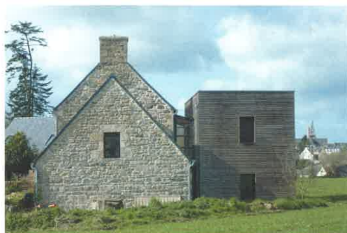
73. EXTENSION DE LA MAISON INDIVIDUELLE À PLOUBEZRE (22) ISABELLE GAVARD-GONGALLUD 2006 - LAURÉAT - HABITAT INDIVIDUEL EXTENSION - RÉHABILITATION
